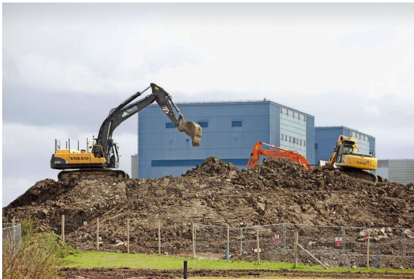
Ohne Staatshilfen nicht möglich: Der AKW-Neubau in Hinkley Point (Grossbritannien) von EDF Energy für geschätzte 34 Mrd. €.
